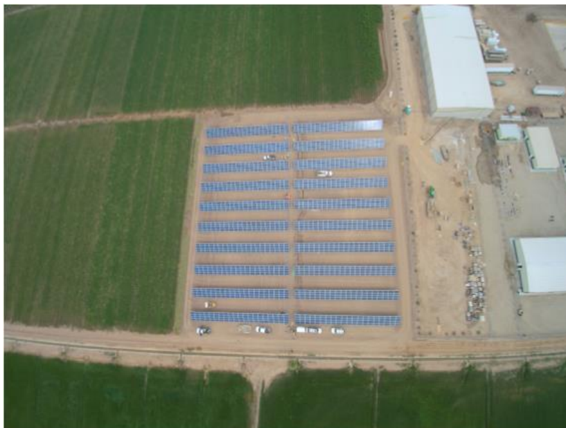
ソーラーフロンティア製 CIS 薄膜太陽電池が採用された米メキシコ州の太陽光発電所 (写真提供：エニルソ社)
