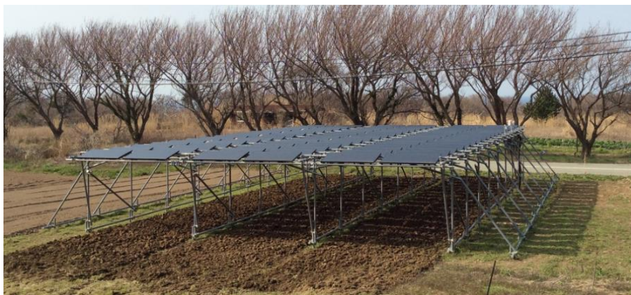
新潟県佐渡島での「営農型発電」実証で採用された CIS 薄膜太陽電池パネル
