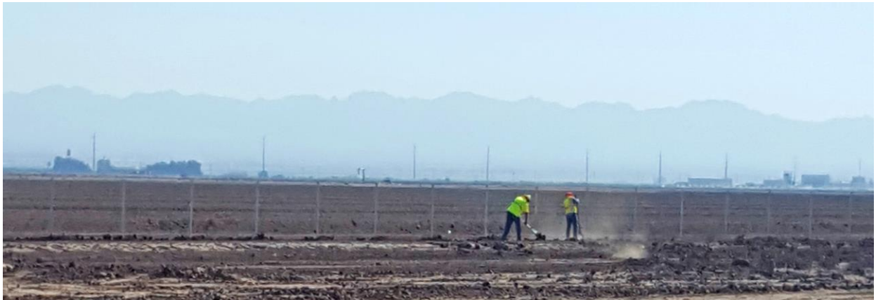
「ミッドウェイIプロジェクト」の建設地で着工準備をする作業員の様子
