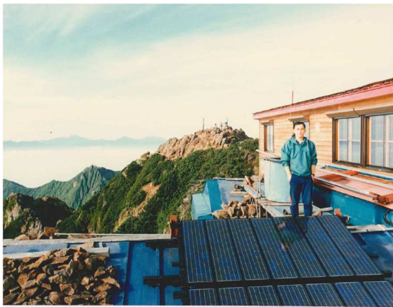
1986年、NEDOの実証事業として八ヶ岳の最高峰赤岳の山荘に太陽光発電システムを設置
